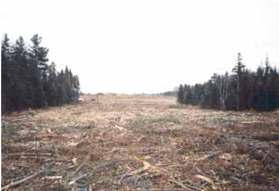
Zone correctement défrichée. Noter qu'il n'y a aucun arbre sur pied.
