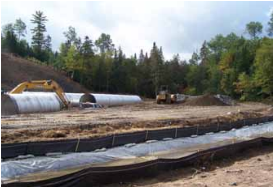
Un canal de dérivation provisoire revêtu de plastique
