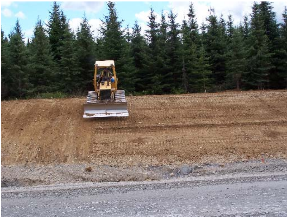
Ameublement de la terre végétale.
