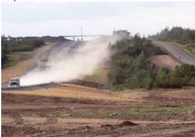
Chantier nécessitant des dépoussiérants.
