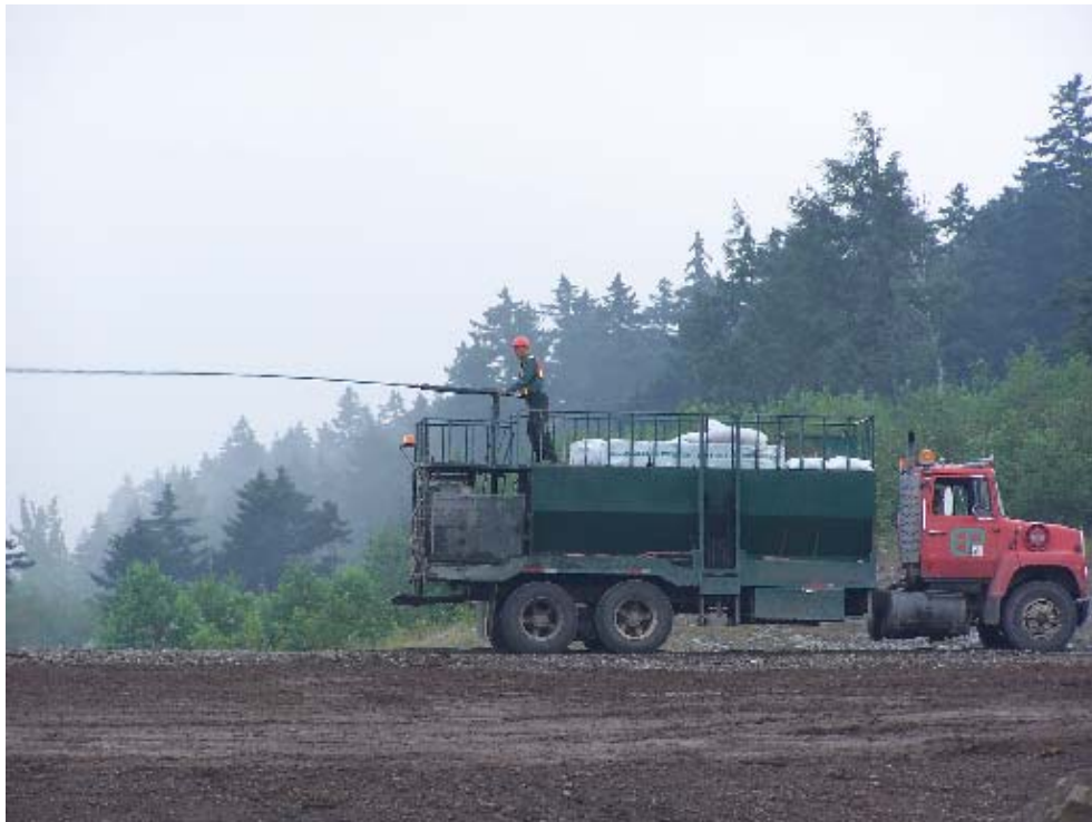
Ensemencement hydraulique — application à l'aide de méthodes mécaniques.
