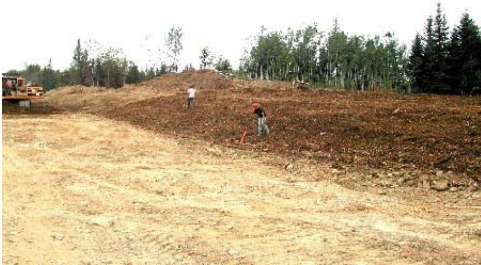
Terre végétale sur un talus arrière. Enlèvement manuel des racines.
