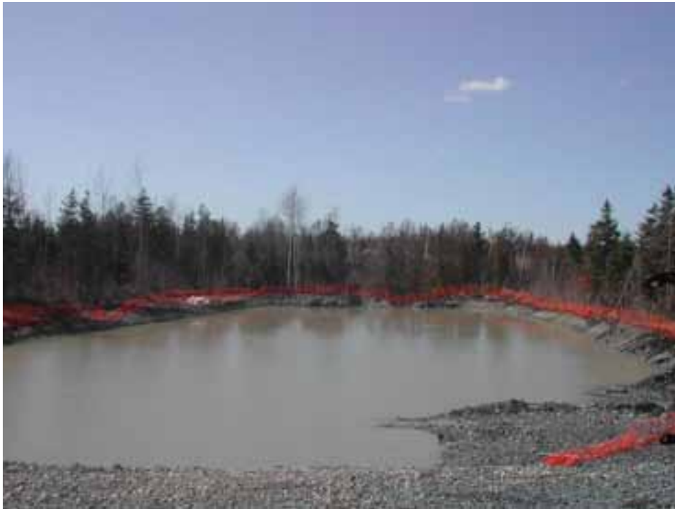
Grand bassin de décantation avec barrière de sécurité
