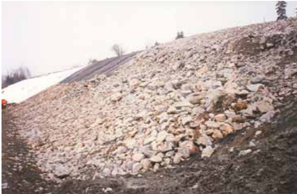
Mise en place d'un perré sur un talus arrière.
