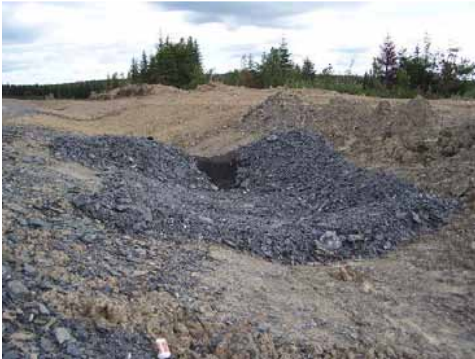
Ouvrage de lutte contre l'érosion de type A terminé
