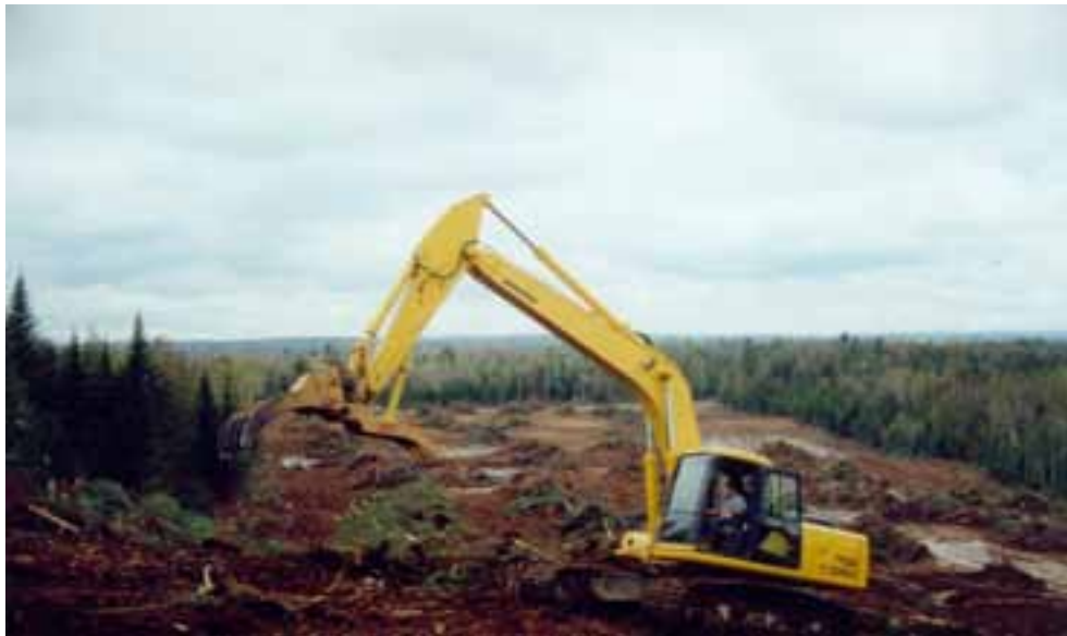
La dessoucheuse est fixée à l'excavatrice pour extraire seulement les souches et les racines.
