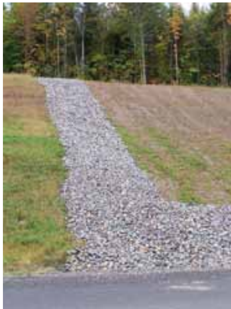
Canaux sur appuis terminés (tuyaux de drainage inclinés)
