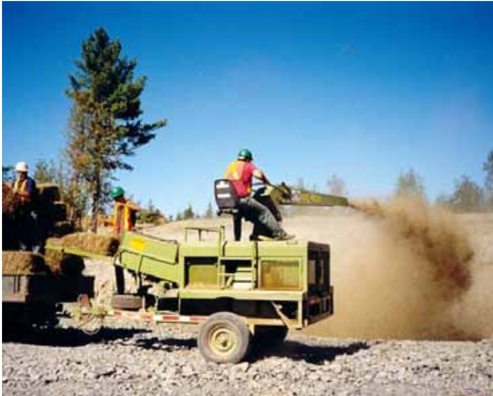
Paillage – application à l'aide de méthodes mécaniques.
