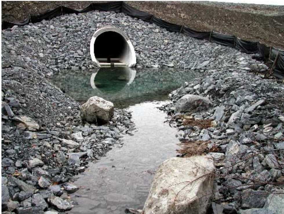
Perré utilisé comme protection d'un ponceau et d'un chenal.
