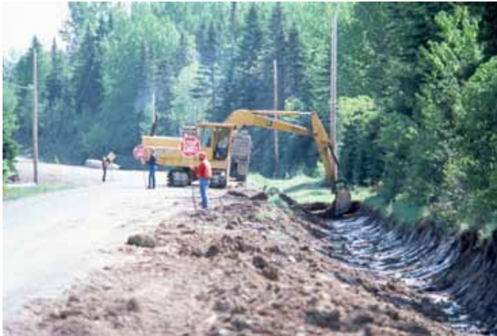
Travaux de creusement d'un fossé.
