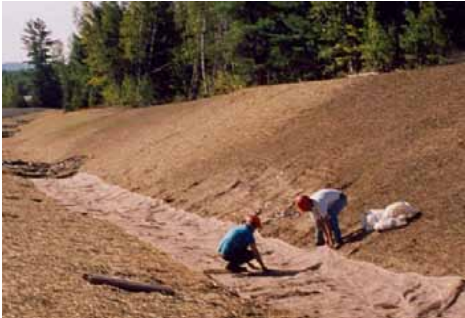
Mise en place de toiles de jute dans un fossé.
