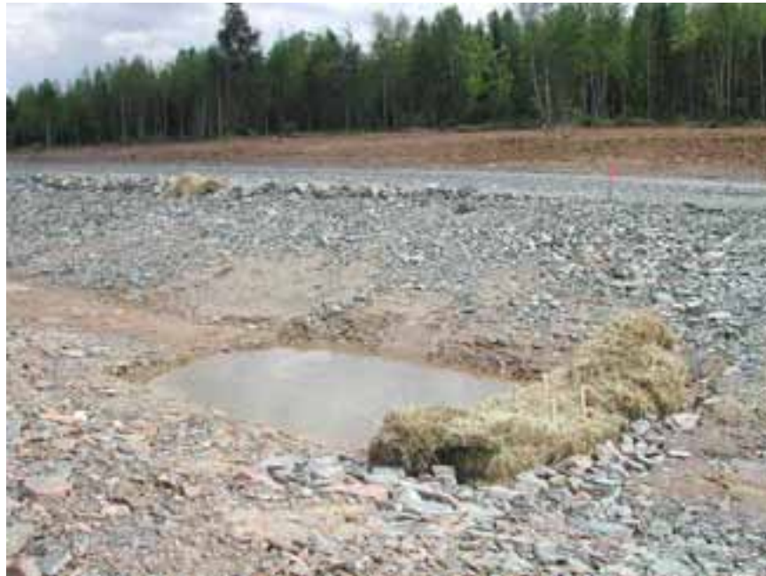
Ouvrage de lutte contre l'érosion de type D terminé
