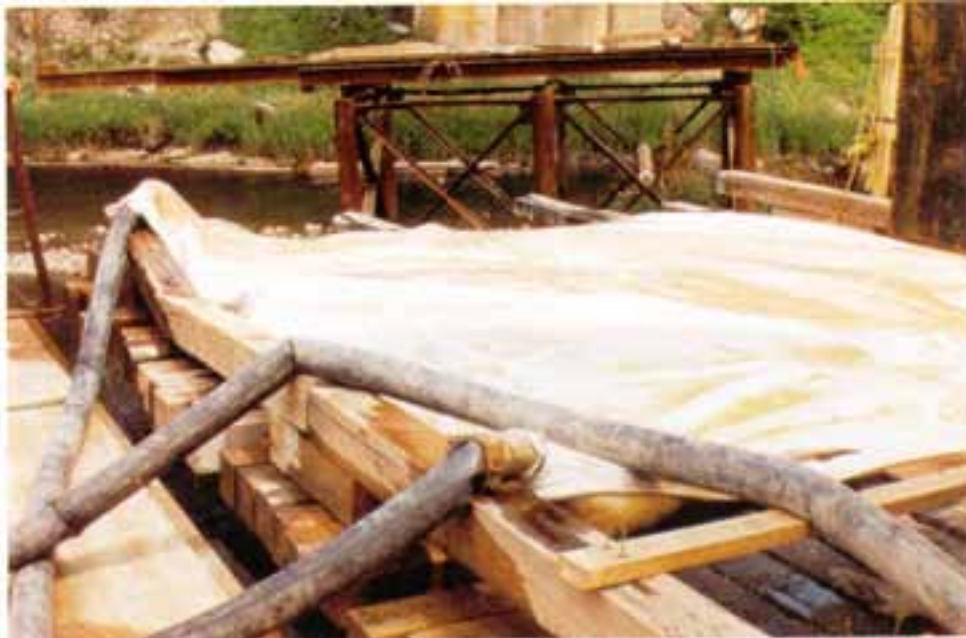
Sac filtrant installé sur un ouvrage d'accès temporaire avant l'assèchement.
