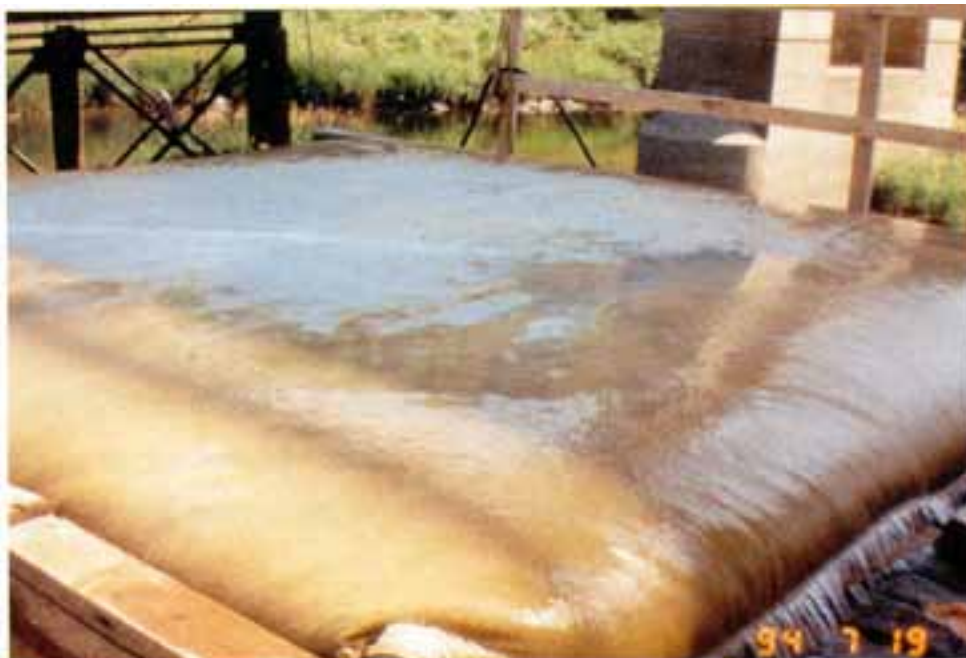
Sac filtrant après le début de l'assèchement. Les sédiments sont retenus dans le sac et celui-ci est transporté dans un site d'élimination approuvé après utilisation.
