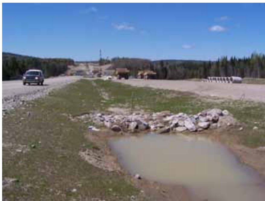
Ouvrage de lutte contre l'érosion de type B terminé
