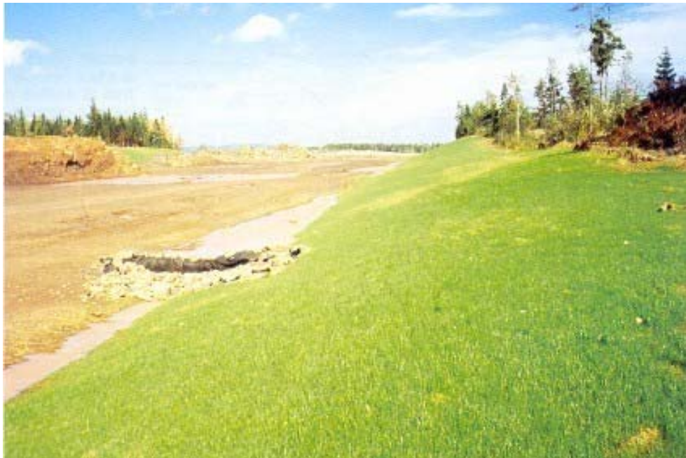
Ouvrage de lutte contre l'érosion de type C terminé
